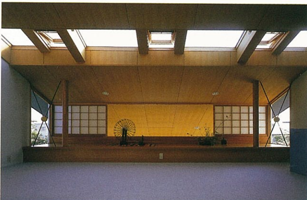
トップライトをスリット状に切り、屋根裏の天井高を確保している。 ガラス屋根とベルックスを組合せ、通風が得られる。
