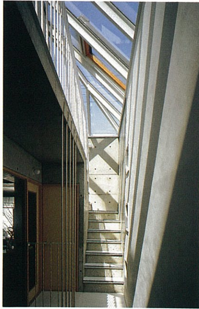
上へと取り入れられた光は、ボイドを通して下へと導かれる。
