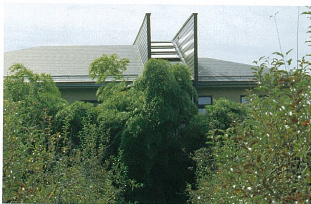
西陽の遮断と 遮音効果をねらい、 2枚の垂直パネルを設けた。
