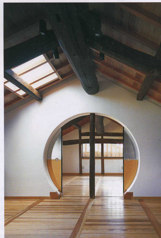
加須山の納屋 再生では既存の耐力壁の量を減らすことなく開口部を設けられる天窓による採光が有効。新設の間仕切壁は梁間方向の耐力壁としても働く。
