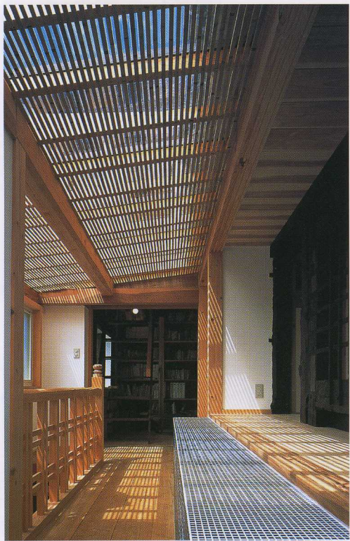
松江の蔵 階段室を兼ねたサンルーム。全面ガラス屋根の下に、割竹のルーバーをとりつけ、やわらかい光を入れる。
